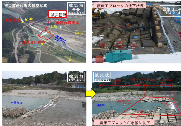
床止工の被災事例
