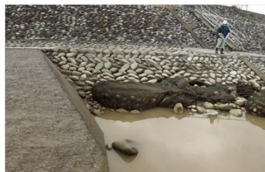
急流河川での護岸被災事例
