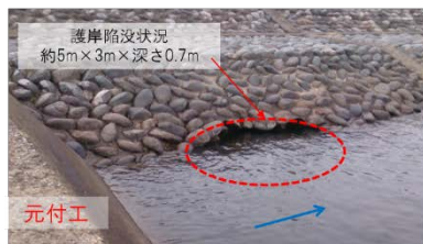
令和元年東日本台風時の千曲川洗掘状況
