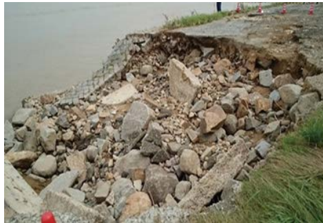
「護岸破損状況 (例)」
