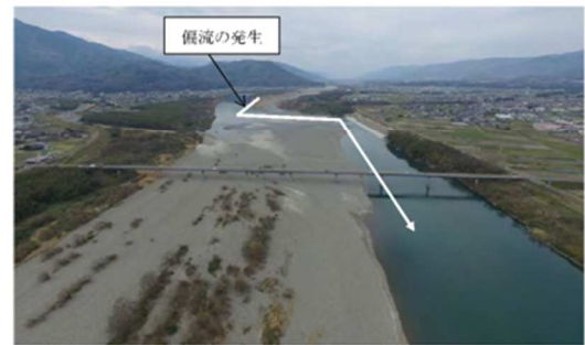
被災時の流路(下流から上流を望む)
