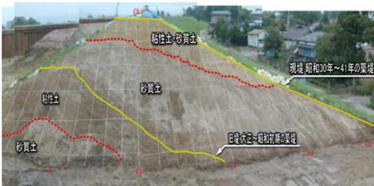
堤防開削時の調査による築造履歴
