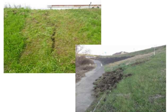
堤防の破損状況（例）
