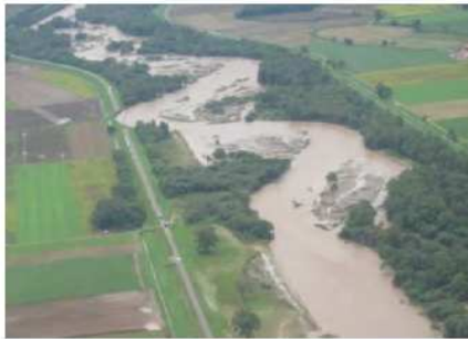
平成23年9月出水時の状況 (十勝川水系音更川)
