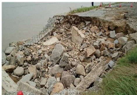
「護岸破損状況(例)」
