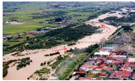
出水時の状況
