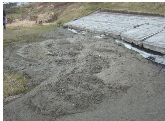
写真-2 高水護岸等の被災状況（近景）
