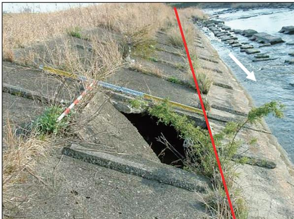
写真－1 護岸陥没状況
