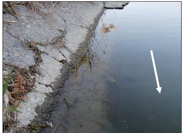
写真－2 陥没箇所付近護岸水際部
