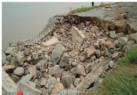
「護岸破損状況(例)」
