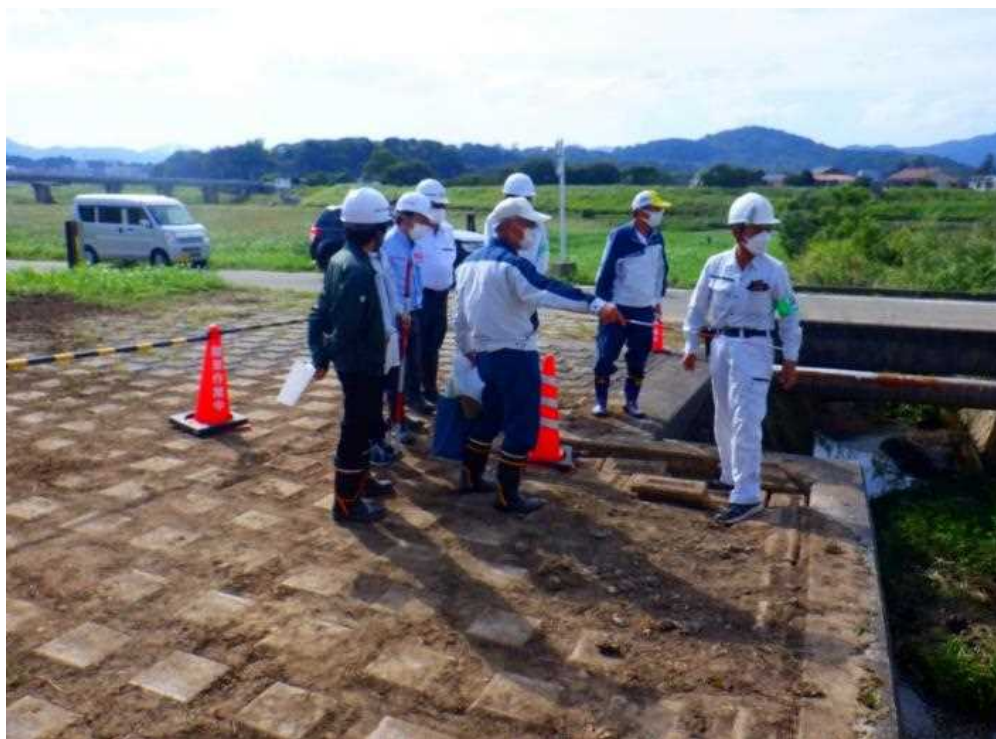
▲変状箇所を確認
