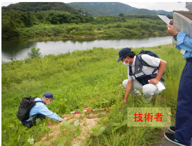
法面の侵食状況計測
