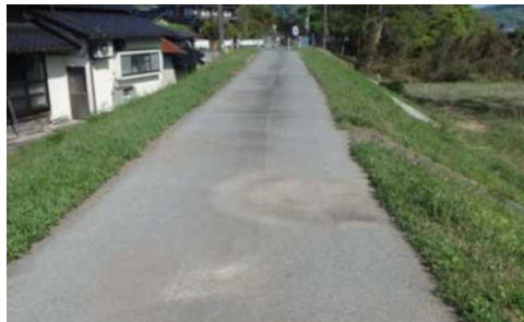
巡視により確認された堤防天端の微小な不陸
