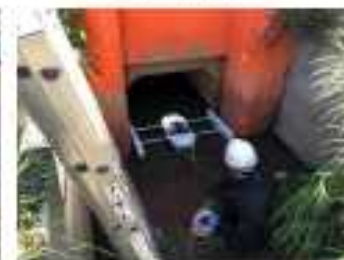
函体幅に合わせてフロート幅を調整→直進性確保
