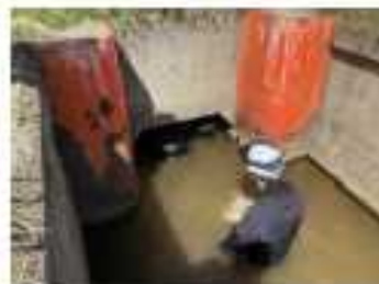
函体幅に合わせてフロート幅を調整→直進性確保
