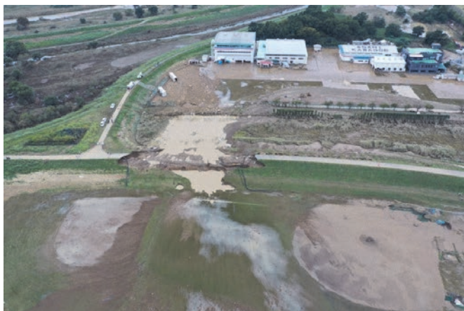
図－4 決壊箇所付近の川表部及び高水敷の状況
