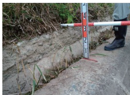
(b) 低水護岸の沈下状況 (沈下量30cm程度)
