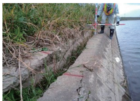
(b) 低水護岸の沈下状況 (沈下量30cm程度)
