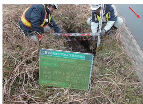
(a) 低水護岸背後の陥没 (幅70cm、深さ1m程度、延長22m区間に5箇所程度)
