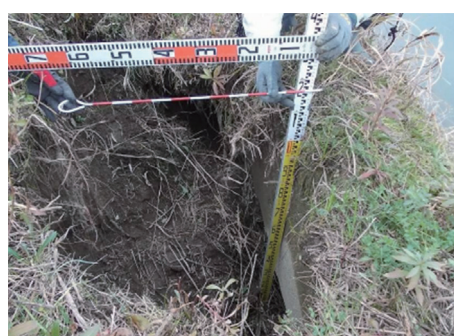
(a) 低水護岸背後の陥没 (幅70cm、深さ1m程度、延長22m区間に5箇所程度)
