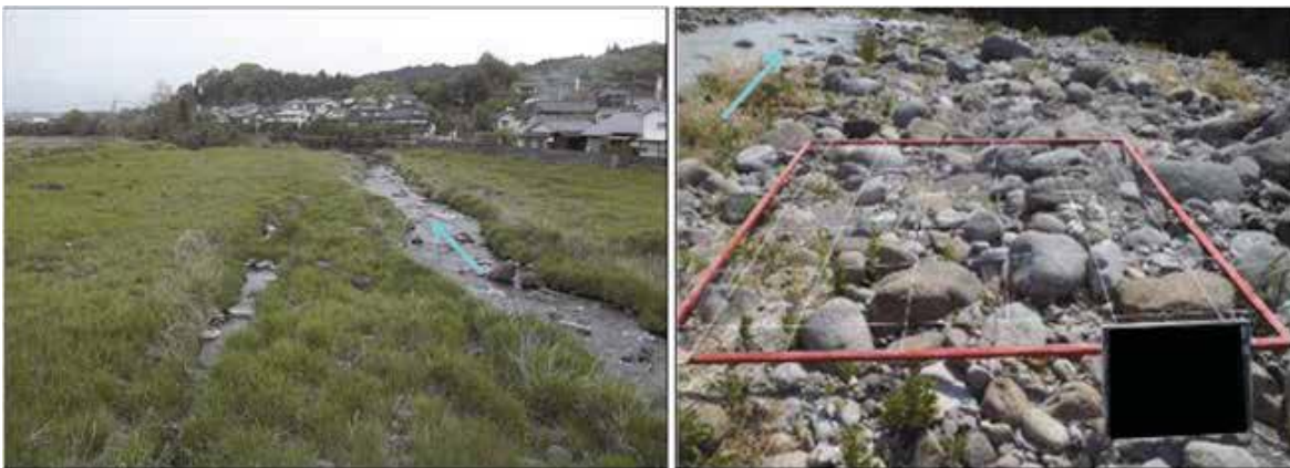
(a) 点検時に橋梁上から撮影した河道の状況 (b) 面格子法による河床材料調査(格子間隔=20cm)
