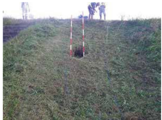
写真-2 樋門周辺堤防のり面沈下・陥没
