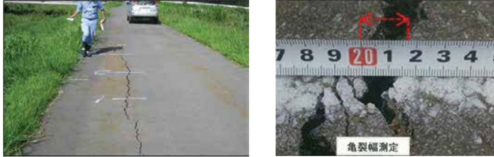
写真-1 平成30年5月の天端亀裂状況
