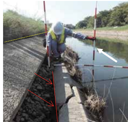
写真-1 低水護岸等の被災状況（全景） 写真-2 低水護岸等の被災状況（近景）
