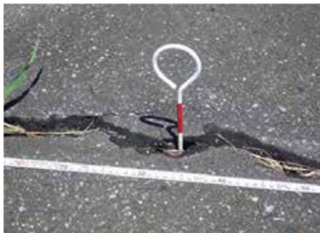
写真-2 令和元年5月下旬の亀裂
