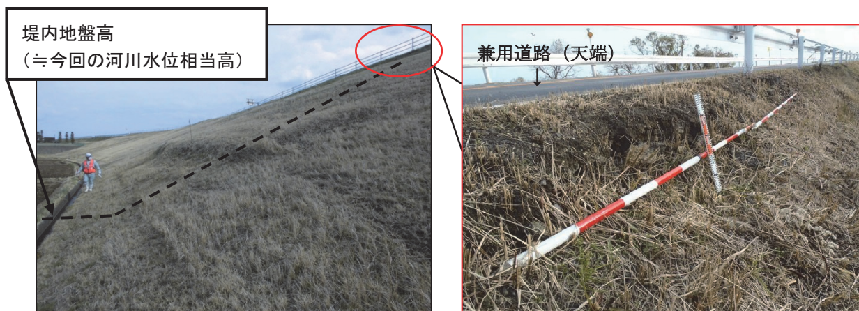
写真-1 堤防のり面の表層すべり (全景)
