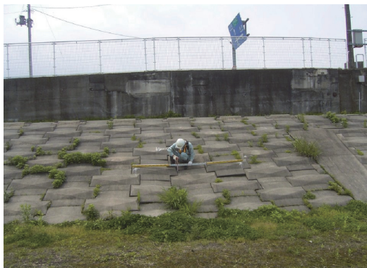
写真－1 高水護岸の陥没（全景）
