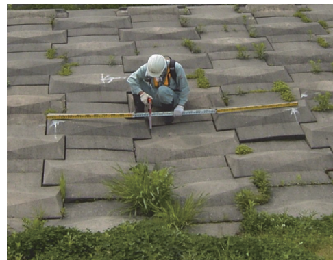
写真－2 高水護岸の陥没（近景）
